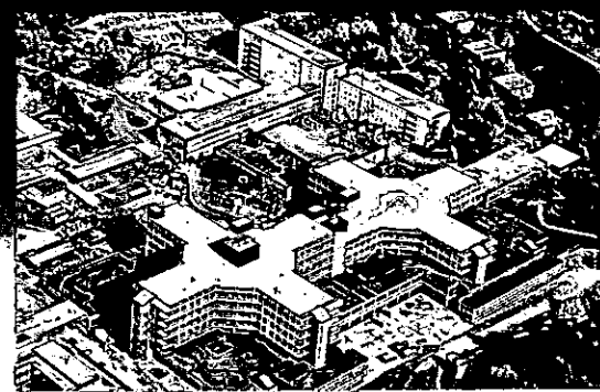
Beispiel für erfolgreiches LTG Anlagen- und Energie-Management: Universitätsklinik GRONA, Tübingen
