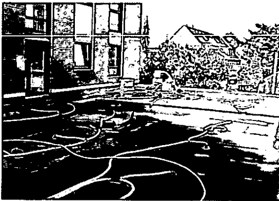
Trocknung eines Flachdaches
