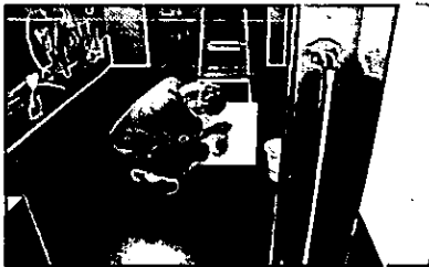
Reinigen und desinfizieren der Luftauslässe
