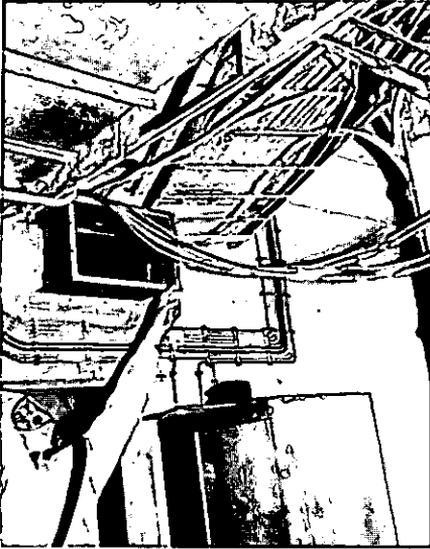
Abb. 3: starke Beschädigungen an asbestummantelten Kabeltrassen
