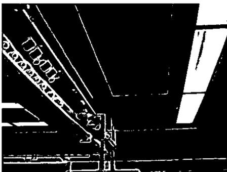
Die Innenseite der Medienbrücke kann 3-seitig mit 2 V2A-Geräteträgerschienen 25x10 mm, zur Aufnahme von Wagensystemen der Serie 3600 und dem entsprechendem Zubehör ausgestattet werden
