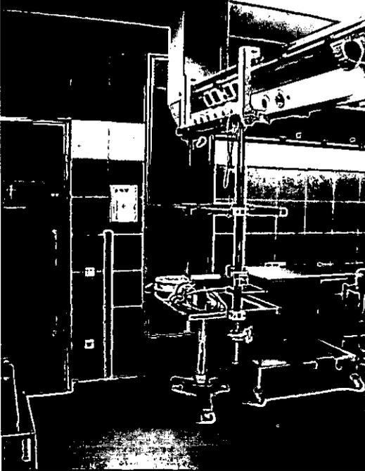
Der Luftaustrittsbereich ist 4-seitig mit einer Abschottung aus Plexiglas umgeben, um die laminare Strömung der Zuluftdecke im Deckenbereich zu gewährleisten.
